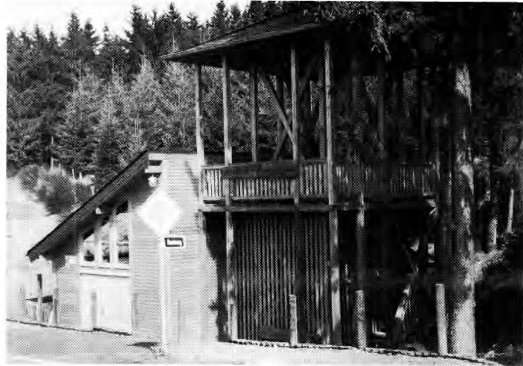
Teil des Geo-Lehrpfades ist auch der Mühlenberger Stollen im ehemaligen Bleibergwerk »Neue Hoffnung« in Bleialf. Hier wird dem Besucher ein realistischer Eindruck von der Arbeit unter Tage vermittelt. Unser Foto zeigt das Einstiegsgebäude.
